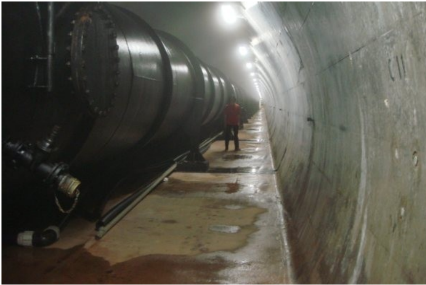
Tuyau traversant le Barrage du Salagou
