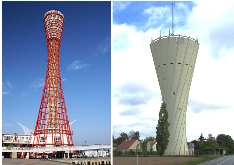
FIGURE 4.1 – Deux hyperboloïdes à une nappe : la tour du port de Kobe au Japon et le Château d’eau des Essarts-Le-Roi
